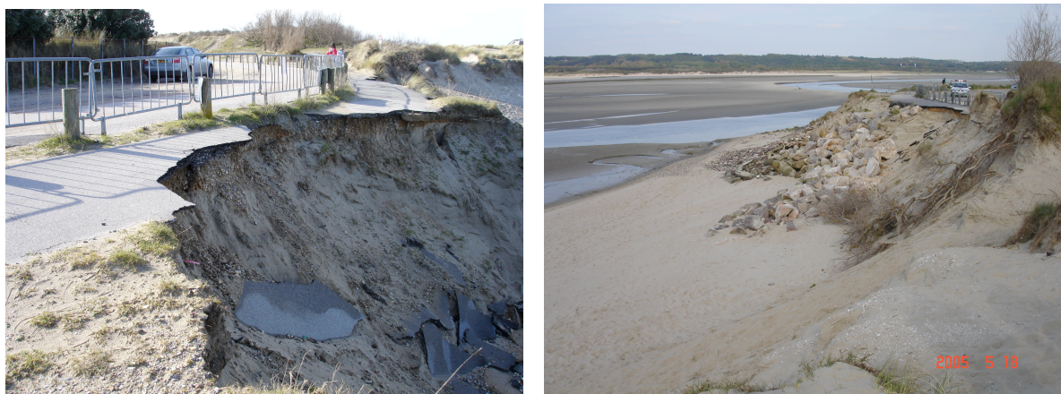
Figure 2 : Pointe du Touquet. Effets de l'érosion marine sur la route en corniche. A gauche, situation le 15 février 2007. A droite (18 mai 2005), l'enrochement de 2002 est déjà déstabilisé. Le chenal de la Canche longe la rive sud et contribue à entretenir la raideur de la plage en contrebas de la falaise. Noter le déracinement des arbustes. Il n'y a pas d'apport éolien dans ce secteur (photos Y. Battiau-Queney).
