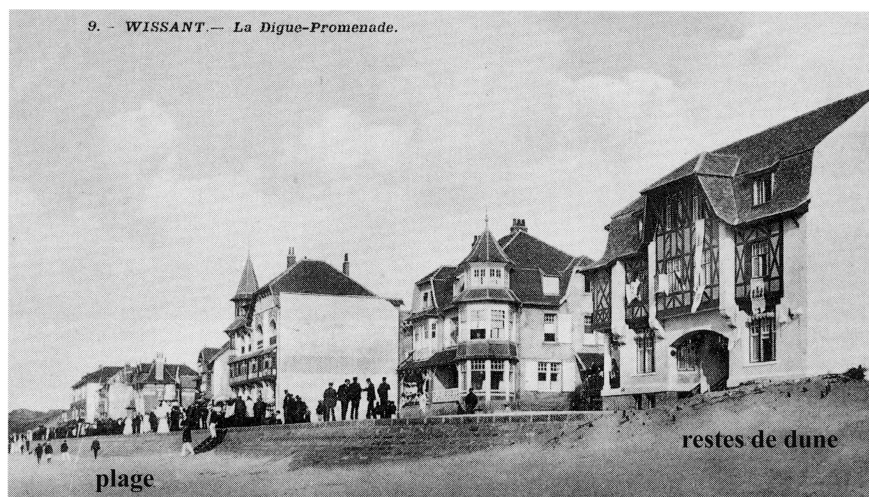
Figure 5 : La digue-promenade avant la Grande Guerre. La chaussée et les maisons sont établies sur l'ancienne avant-dune, dont on aperçoit des éléments résiduels à droite de la photo. Le sable de la plage recouvre en partie le perré qui épouse la forme de l'ancien talus dunaire (Source : Gallois, 2002).
